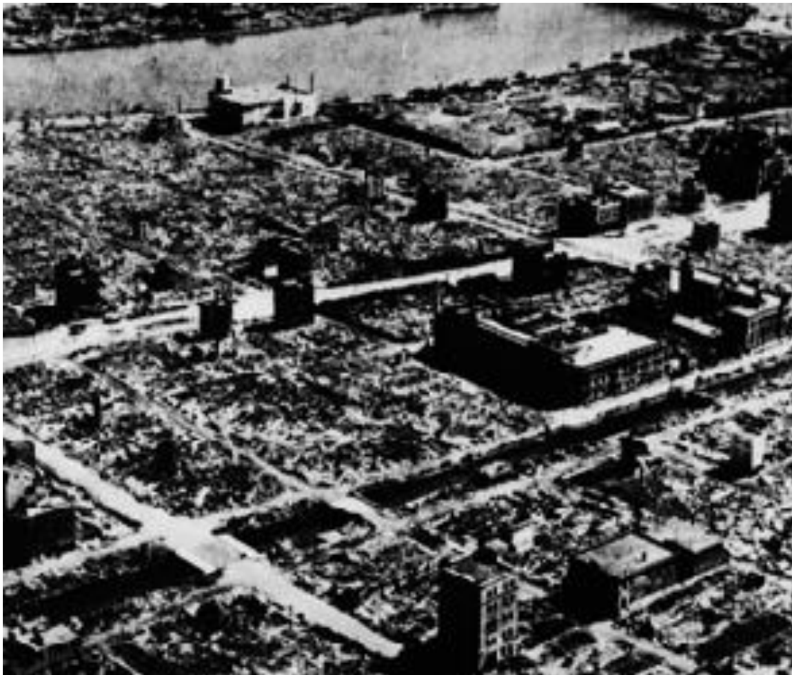
Abbildung 6 Zerstörte Produktionsanlagen bei Mitsubishi Motors
